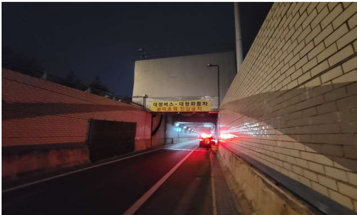
Ramp-D 갭문 진입부 전경
