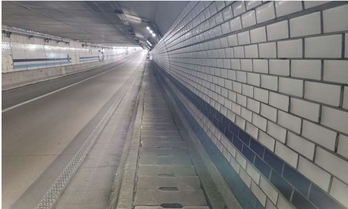
NATM구간 공동구 전경
