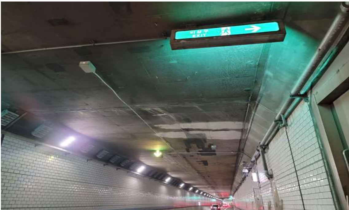
BOX구간 슬래브 전경
