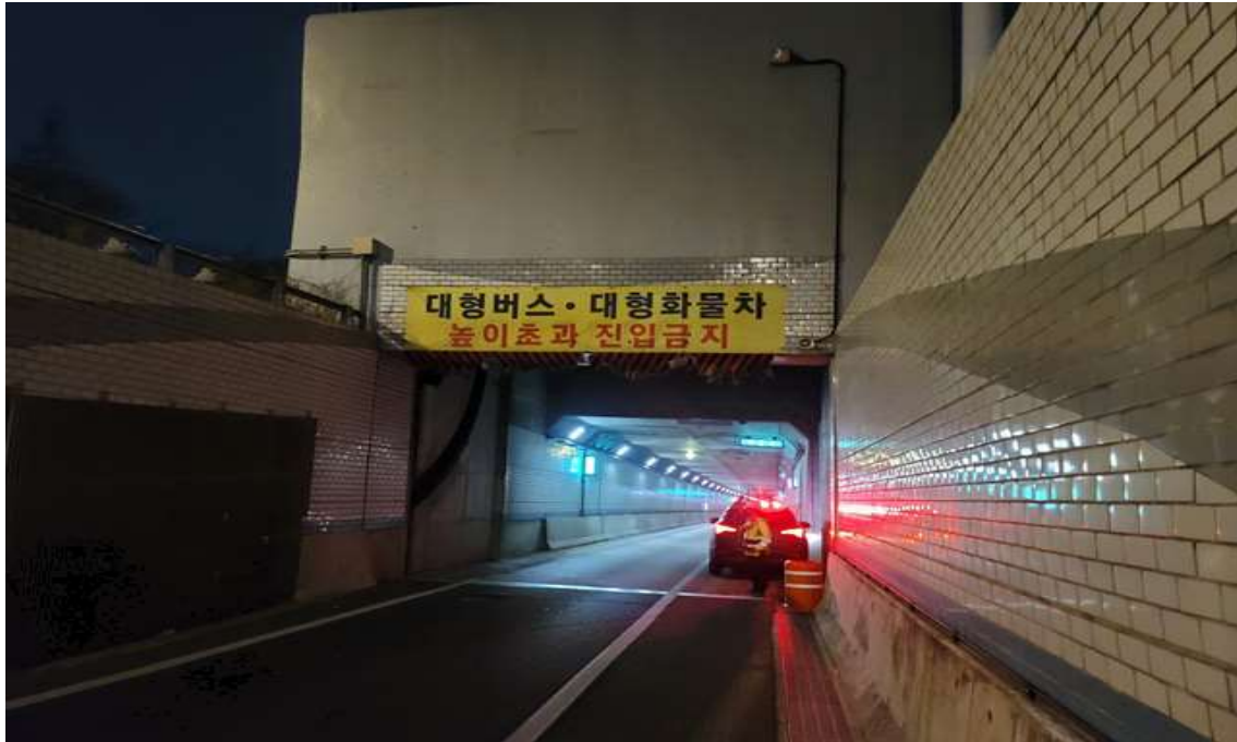
RAMP-D 갭문 전경
