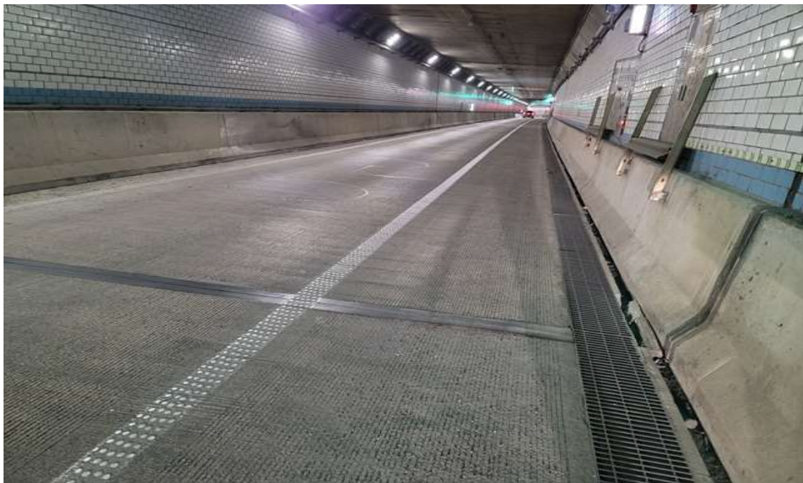
BOX구간 포장 전경
