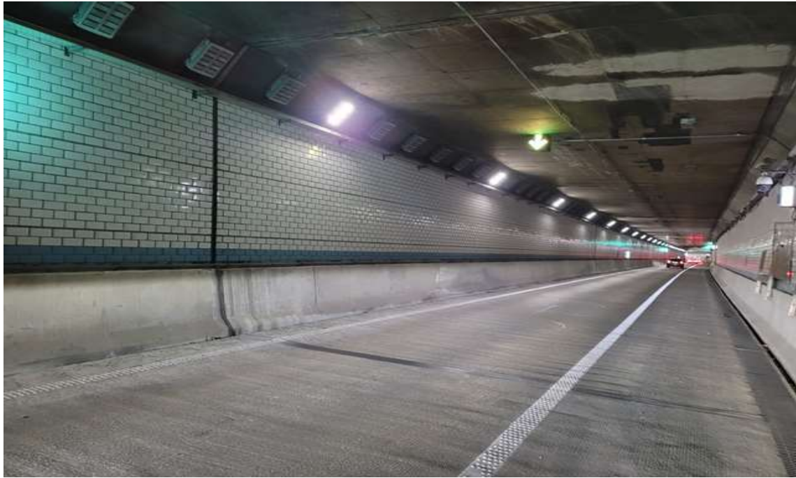
BOX구간 벽체 전경
