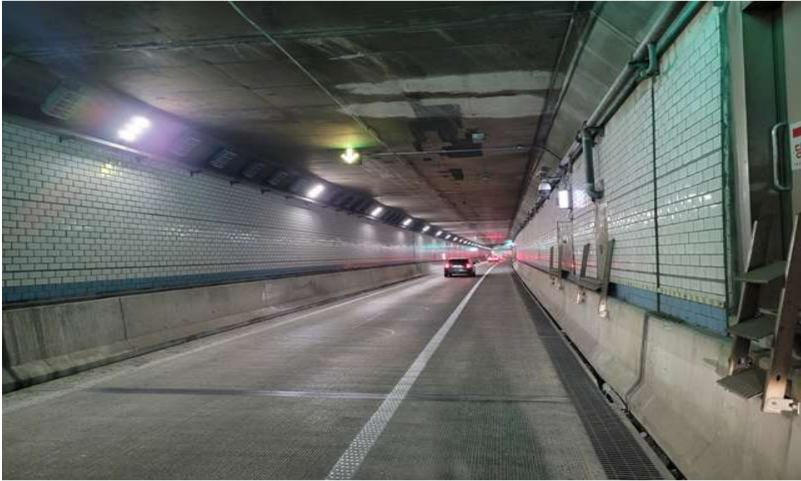
BOX구간 내부 전경
